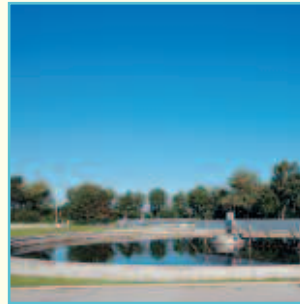
Bei der Kläranlage Wulkaprodersdorf kommt die Mischwasserbehandlung im Nachklärbecken schon seit Jahrzehnten zum Einsatz.
