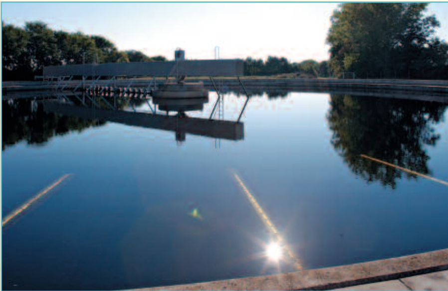
Aufgrund eines neuen Verfahrens können große Mischwassermengen gereinigt werden. (Foto: Regionalmanagement Burgenland GmbH – Walter Luttenberger)
