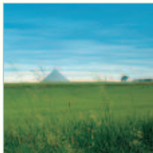
Fernansicht der Biogasanlage Strem. Am Horizont ist die Glashaube zu sehen, unter der sich das Biogas sammelt. (Foto: EEE Güssing)
