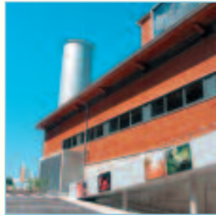
Das Fernheizwerk Toblach-Innichen beliefert die Gemeinden Toblach und Innichen mit Wärme.
