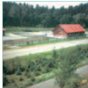
Die Kläranlage Diemelsee-Adorf ist eine Belebungsanlage. Sie wurde für 4.900 Einwohnerwerte ausgelegt und 2003 in Betrieb genommen.
