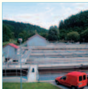
Blick auf die neue Kläranlage Ittertäl. Das Kombibecken (Belebungsbecken und Nachklärbecken) hat ein Nutzvolumen von 16.000 m 3 .
