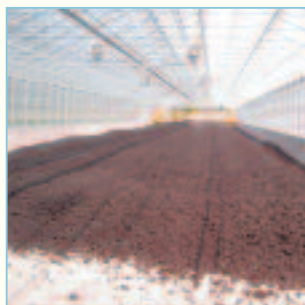
Solare Klärschlamm-trocknung kommt beim Abwasserverband Neufelderseeengebiet zur Anwendung.
