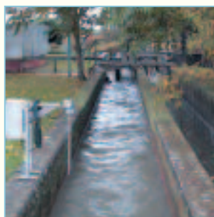
Mischwasser-Bypass in der Kläranlage Wulkatal im Burgenland. (Foto: Amt der Burgenländischen Landesregierung, Abt. 9 - Gewässeraufsicht)
