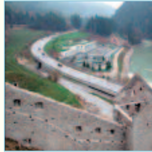
Im Hintergrund ist die Kläranlage Mühlbach zu sehen.
