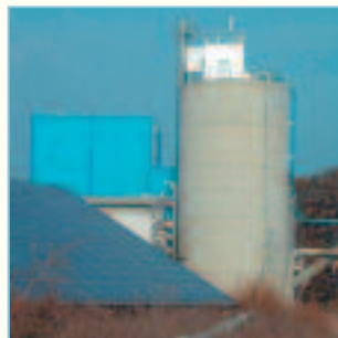
Das Güssinger Heizwerk II mit den Einblasleitungen der Parkettwerke (die graue Leitung im Vordergrund kommt von Meyer Parkett, die blaue im Hintergrund von Weitzer Parkett).
