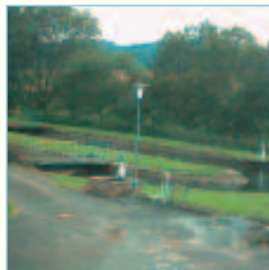
Bei der Kläranlage Sachsenberg handelt es sich um einen so genannten Oxidationsgraben für 2.200 Einwohnergleichwerte.
