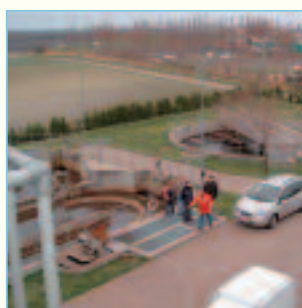
Die Kläranlage Tadtén mit 3.000 Einwohnerwerten.
