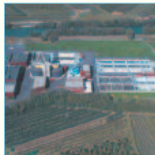
Die Kläranlage Mittelvinschgau – im Gemeindegebiet von Kastelbell/Tschars – hat eine Kapazität von 36.000 EW.
