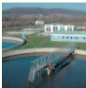
Die Kläranlage Heiligenkreuz ist die größte Abwasserreinigungsanlage im Burgenland.
