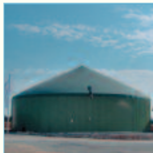
Außenansicht der Biogasanlage in Korbach-Lelbach.
