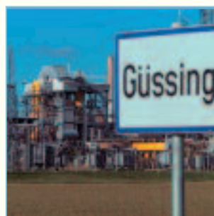
Güssing steht bei der Energieversorgung auf eigenen Beinen – im Hintergrund das Biomasse-Kraftwerk.
