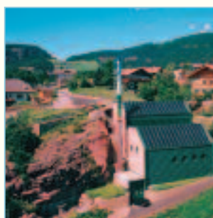
Das Biomasse-Fernheizwerk versorgt fast ganz Vöran mit Wärme. (Foto: Lana Tappeiner)
