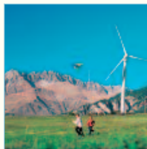
Die erste Südtiroler Windkraftanlage, LTW 62 mit einer Nennleistung von 1,2 MW. (Foto: Leitner-Technologies)
