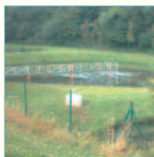
Die Teichkläranlage Frankennau-Ellershausen wurde in den 80er-Jahren errichtet. (Foto: Landkreis Waldeck-Frankenberg)
