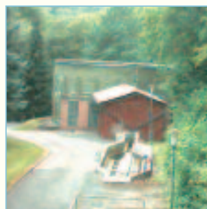
Die Kläranlage Waldeck-West ist eine Tropfkörperanlage für 2.000 Einwohnerwerte. Die Anlage soll durch eine neue Zentralkläranlage in Kürze ersetzt werden.
