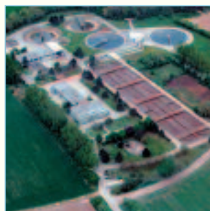
Luftaufnahme der Kläranlage Wulkatal bei Wulkaprodersdorf im Burgenland.
