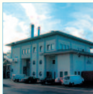
Frontansicht des Fernheizwerks Güssing. Von hier aus wird die Stadt mit Wärme versorgt.
