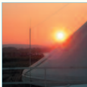
Auch für die Biogasanlage Strem – hier in einer stimmungsvollen Abendansicht – fließen EU-Förderungen.
