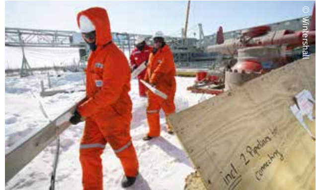
Große technische, logistische und finanzielle Anstrengungen sind erforderlich, um Energie bis zum Endverbraucher zu bringen.
